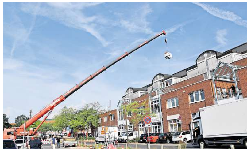
Hoch oben: Der Kran hebt den Kernspintomografen aufs Dach.
