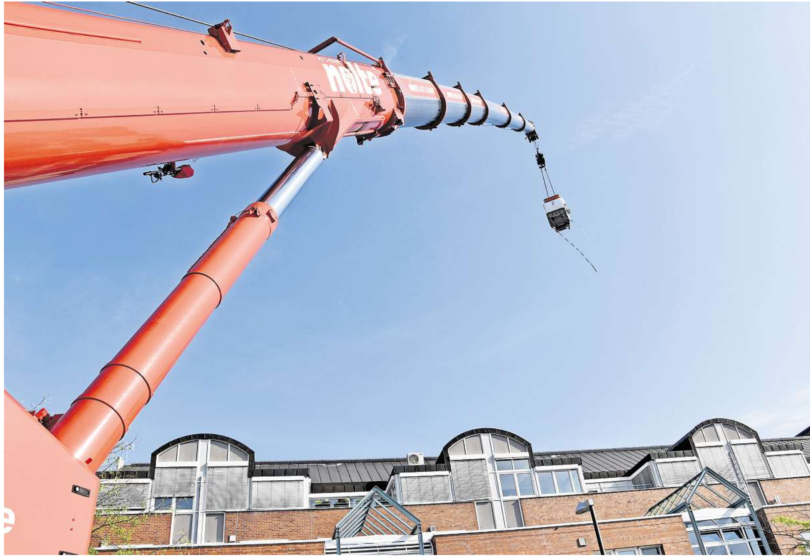
Teure Last: Das MRT schwebt über der Häuserzeile an der Ostpassage.
